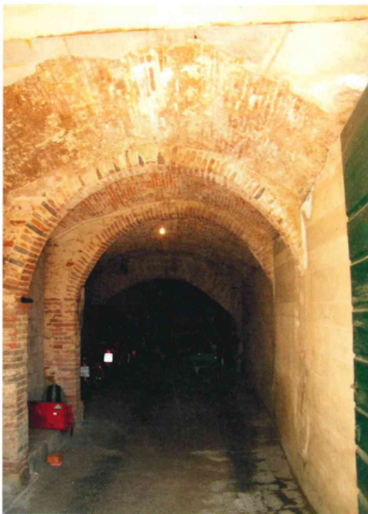
Figura 44: interno dei camminamenti sotterranei.
