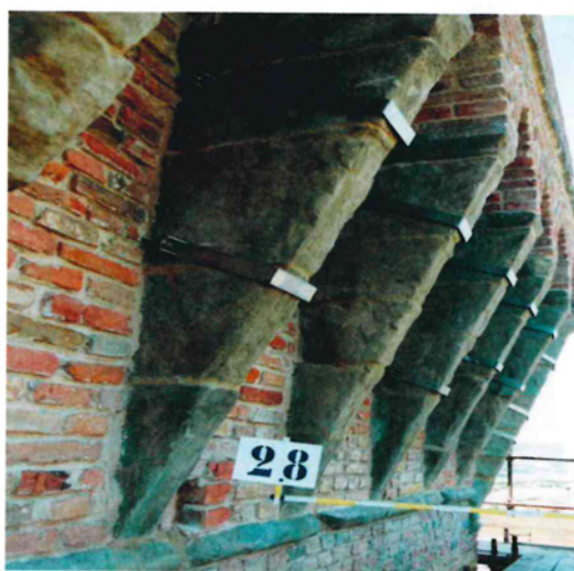
Figura 20: beccatelli a restauro ultimato.
