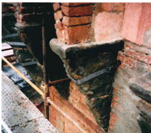
Figura 35: beccatello restaurato con ciarpe metalliche.
