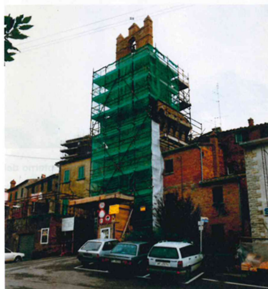
Figura 31: ponteggi alla Porta d'accesso.
