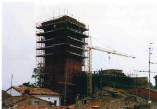
Figura 9: ponteggi installati attorno alla Torre.
