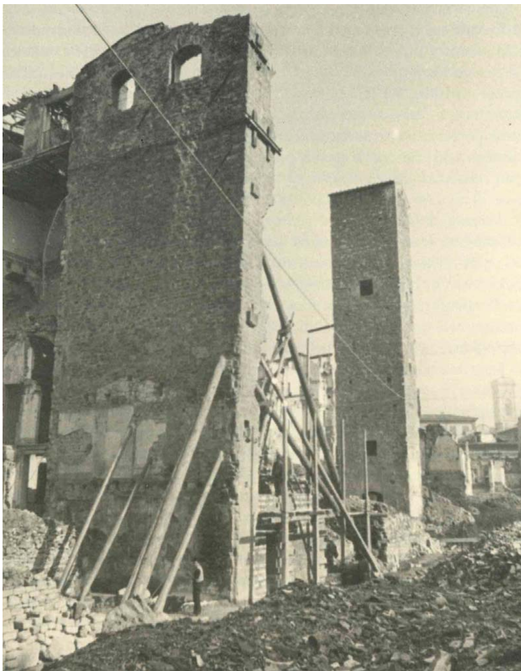
8. La Torre Baldovinetti, restauro ultimato, 1945
